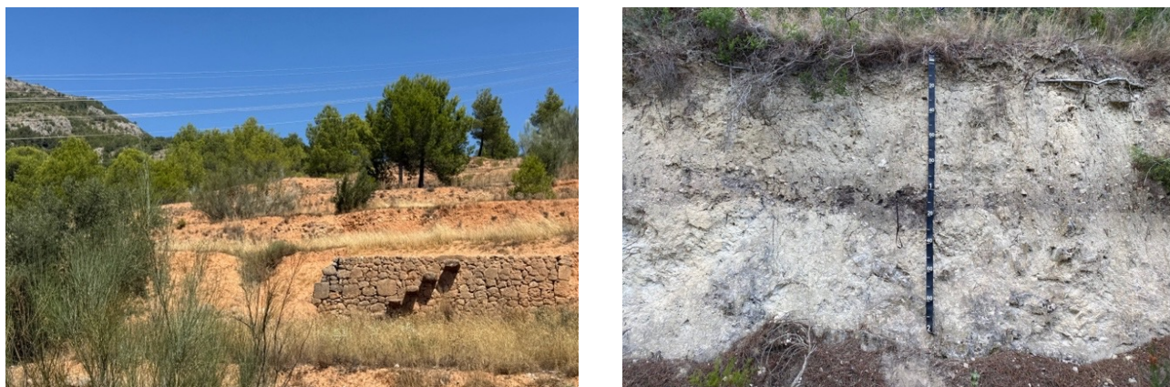
Figura 14. Ejemplo de terrazas con muros de piedra seca parcialmente colapsados (izqda.) y perfil de antigua terraza de cultivo, hoy en día ocupado por masa forestal, donde se observa claramente el suelo original enterrado.
